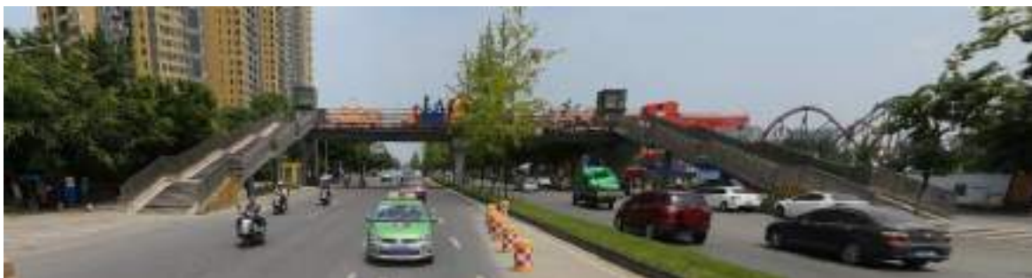
图1-24 现状华侨城过街天桥为混凝土梁桥
